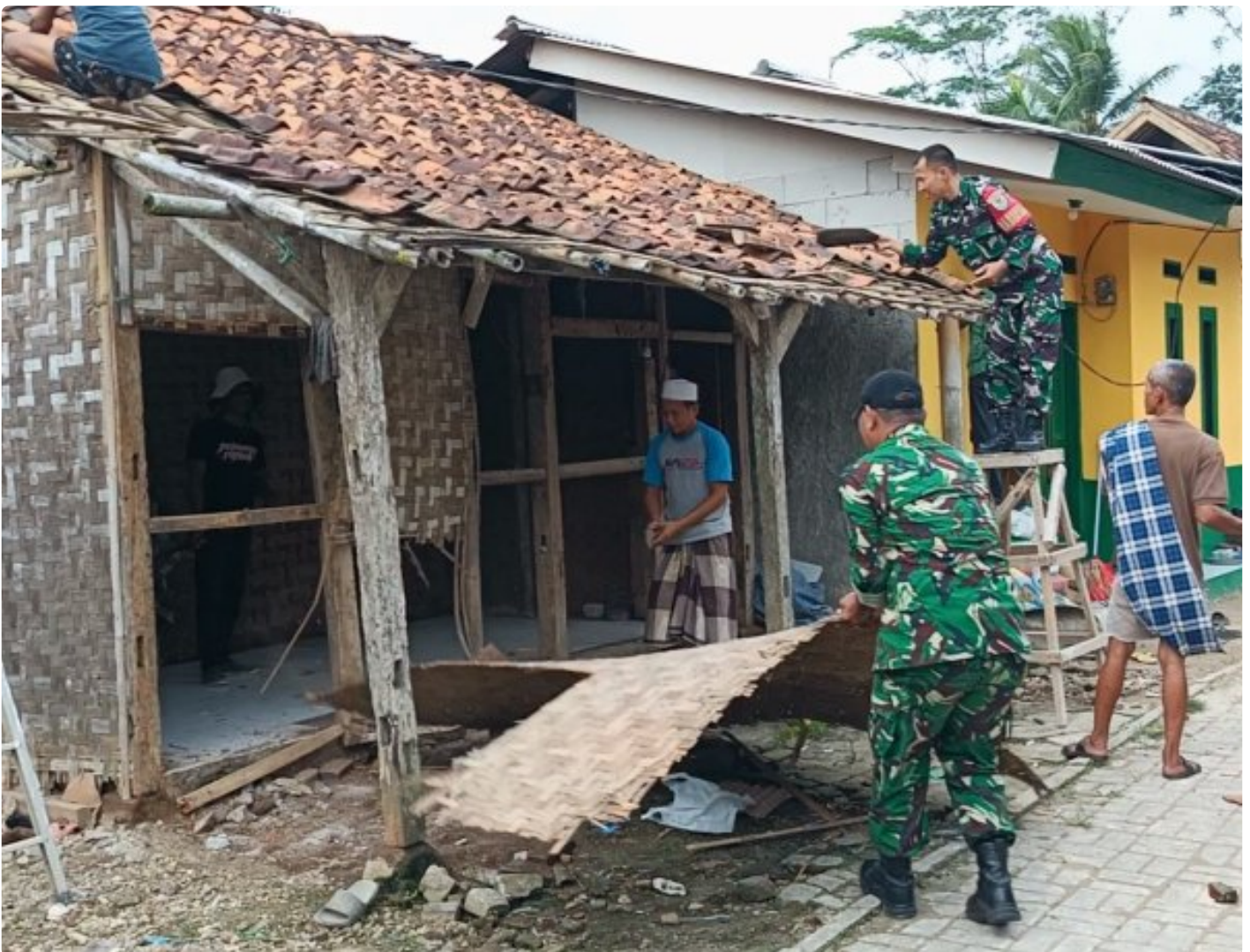
Pembongkaran Rumah Bapak Narmin
